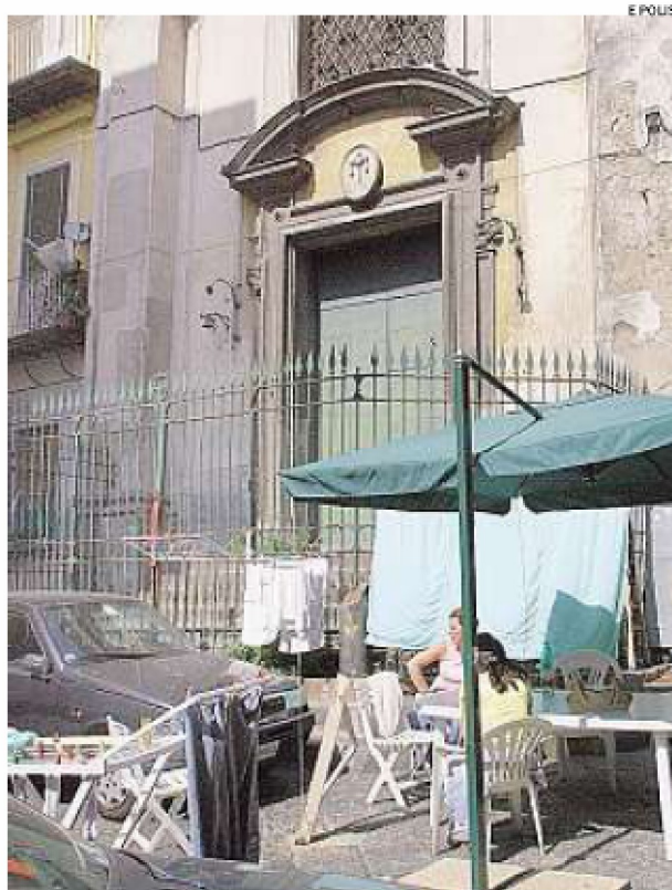
► Degrado fuori alla chiesa di Sant'Agostino alla Zecca
